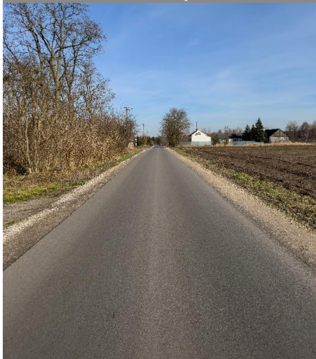
Przebudowa odcinka drogi gminnej w m. Juliopol
