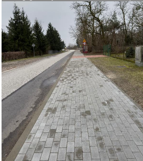
Budowa chodnika w pasie drogowym drogi gminnej w m. Kamion Poduchowny
